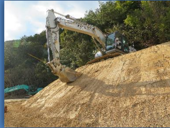
ICTバックホウによる法面整形
