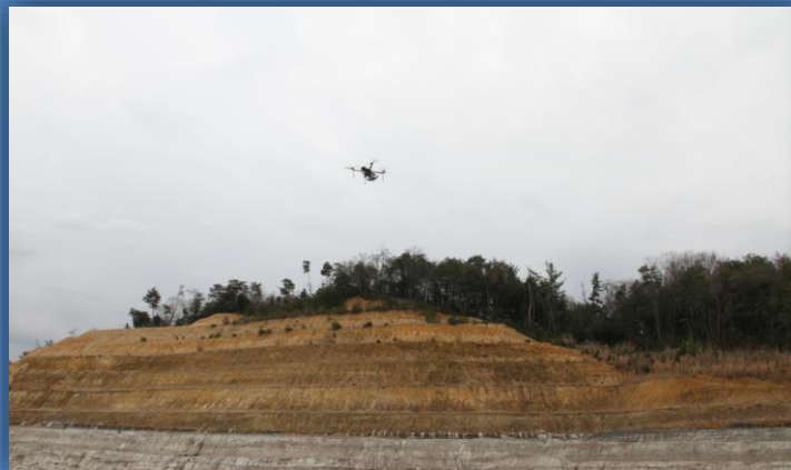
UAV空中写真測量
