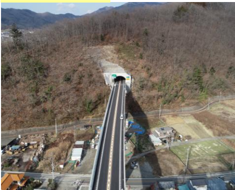
2019.3撮影 かまがりつむぎ 鴨狩津向TN 三沢川橋
