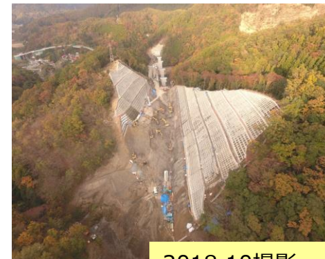
2018.10撮影 ふどうさわかいりょう 不動沢改良工事
