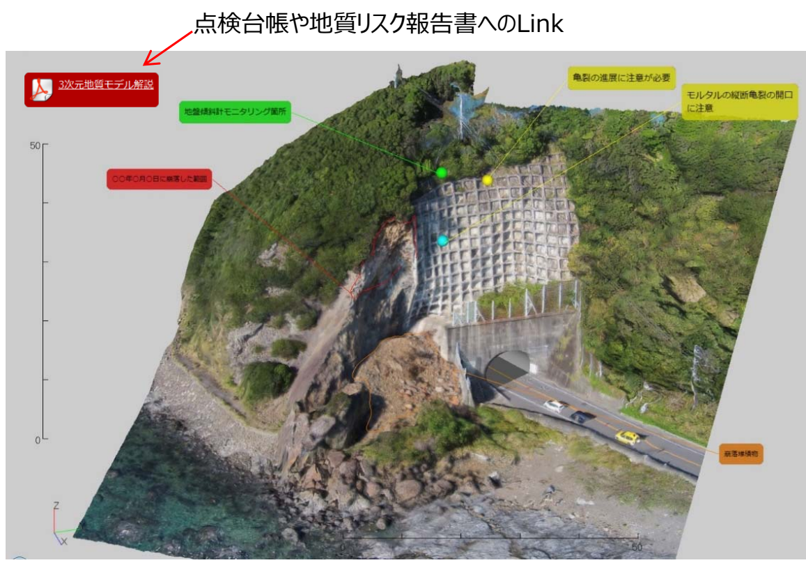
＜斜面点検における地質リスクの表示例※＞
